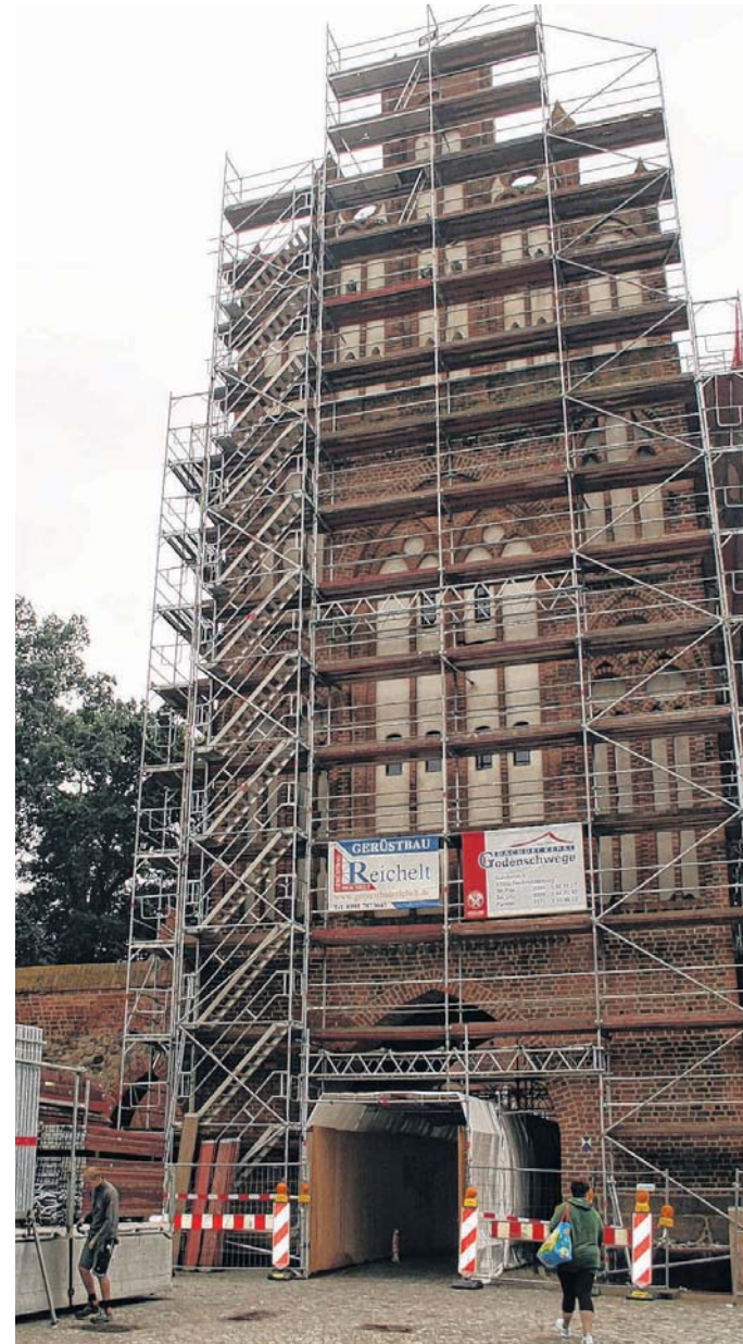
Das höchste der Neubrandenburger Stadttore verschwindet für einige Monate hinter einem Baugerüst.
