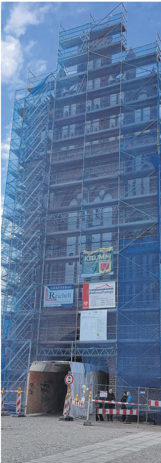
Das Gerüst am Treptower Tor muss noch einige Wochen stehen bleiben.
