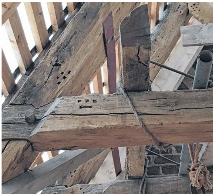
Zeichen vergangener Jahrhunderte: Mit Einkerbungen markierten die damaligen Bauleute, welcher Balken an welche Stelle gehört.
