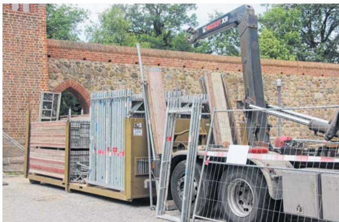
Das Gerüst, das fast ein Jahr zum Inventar des Tores gehörte, ist abgebaut.
