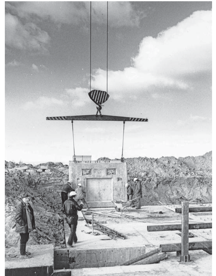
Der Datzeberg wird bebaut. „Das Montagekollektiv Leo Kempin der Taktstraße III des VEB Wohnungsbaukombinates Neubrandenburg setzt die ersten Betonelemente“, war im März 1978 in der Freien Erde zu lesen.
